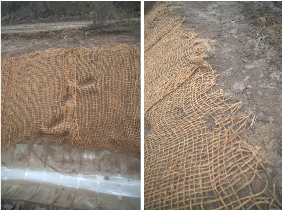
Obrázek 51: Poškození kokosové sítě pohybem pracovníků a nesprávně založená sanační síť.
