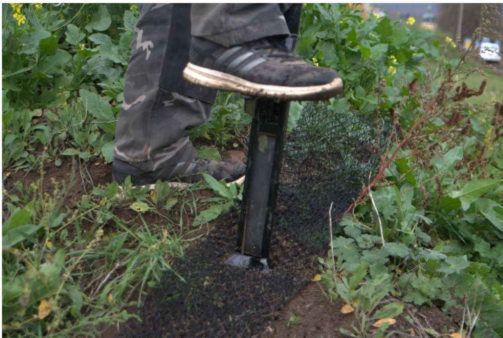
Obrázek 60: Aplikace kotvičky pomocí aplikátoru
