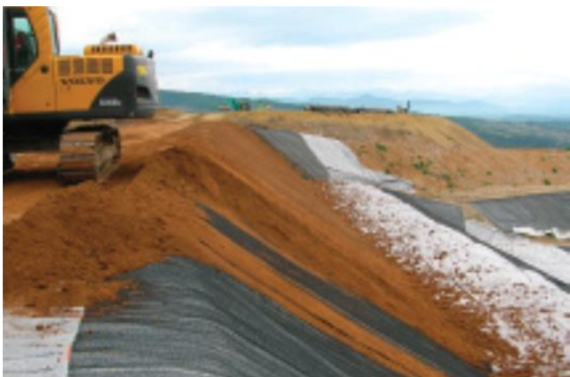
Obrázek 66: Skládka odpadů Forcalquier, France na které byl použit vyztužený typ protierozní matrace Enkamat 7010W/200.50PET (prospekt k výrobku Enkamat).
