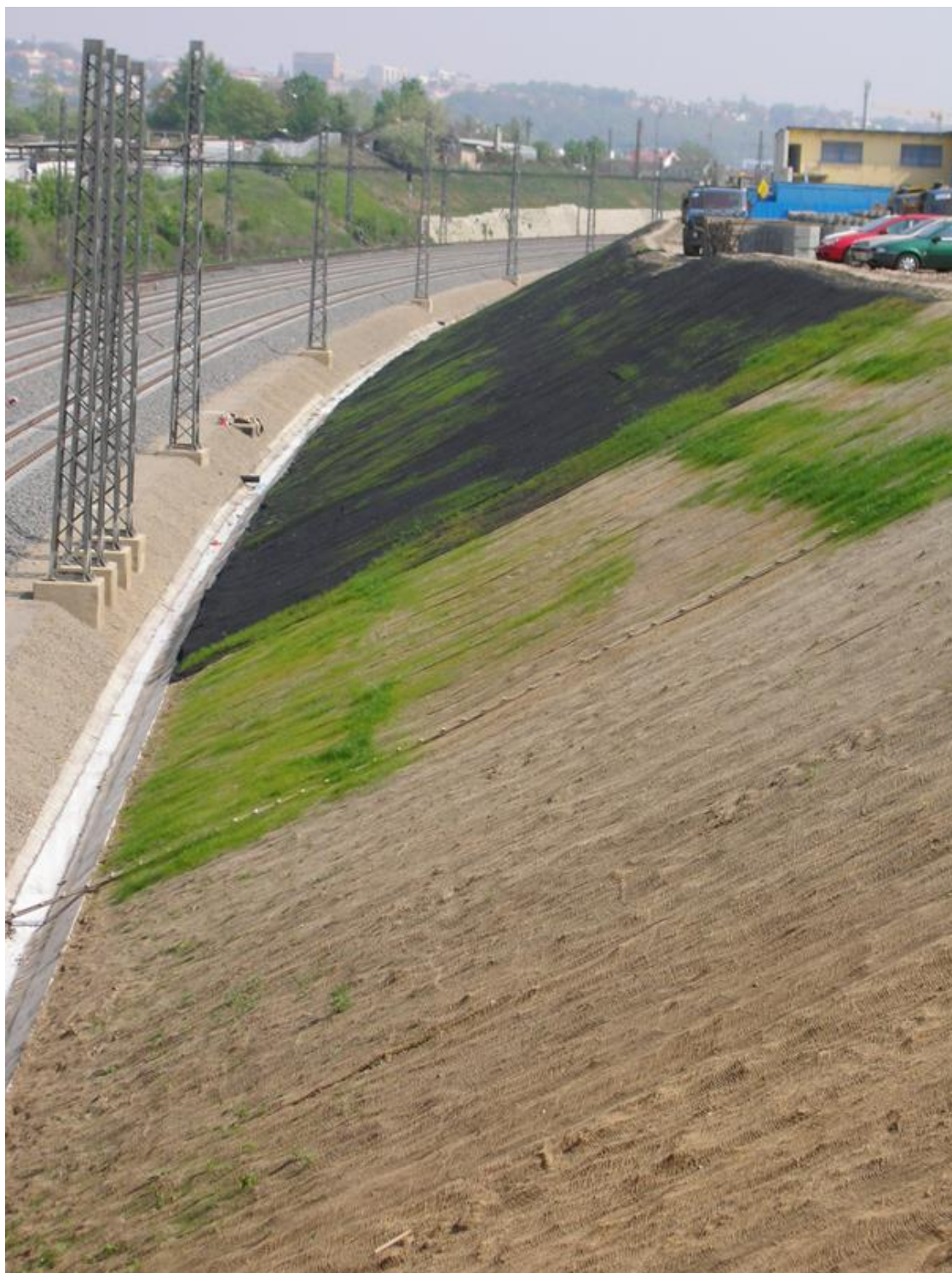
Obrázek 65: Nové Spojení Železniční trať Praha Kolín realizace 2007 aplikace trvalé a dočasné protierozní ochrany nového svahu zářezu (Vaníček, J.)
