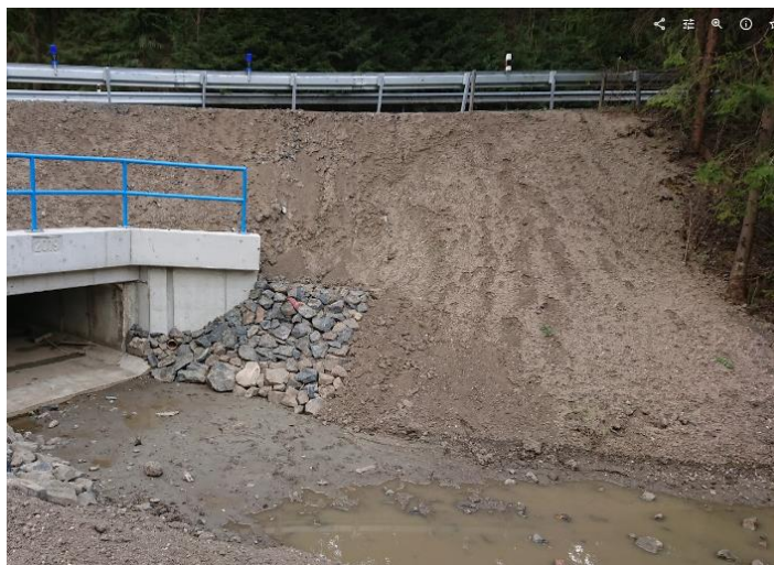
Obrázek 67: Neošetřený svah křížení vodního toku s liniovou stavbou (Kavka P.)
