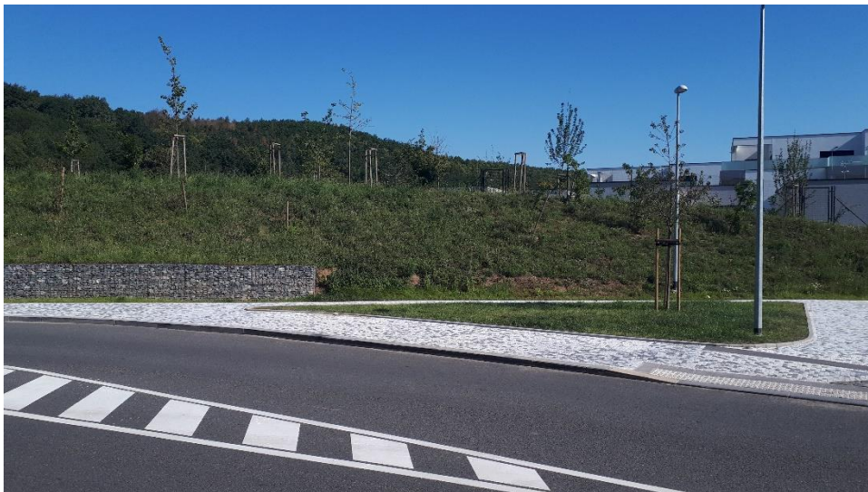
Obrázek 69: Protihlukový val oddělující nově vznikající bytovou výstavbu od frekventované komunikace Klikatá, Praha 5 Radlice.
