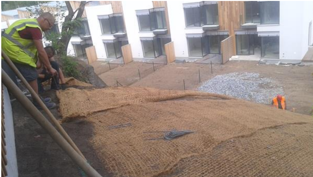
Obrázek 68: Bytová výstavba v Šáreckém údolí na Praze 6, kde bylo třeba přemodelovat, stabilizovat a následně protierozně opatřit nově vzniklý svah zářezu v bezprostřední blízkosti pozemků budovaných RD.
