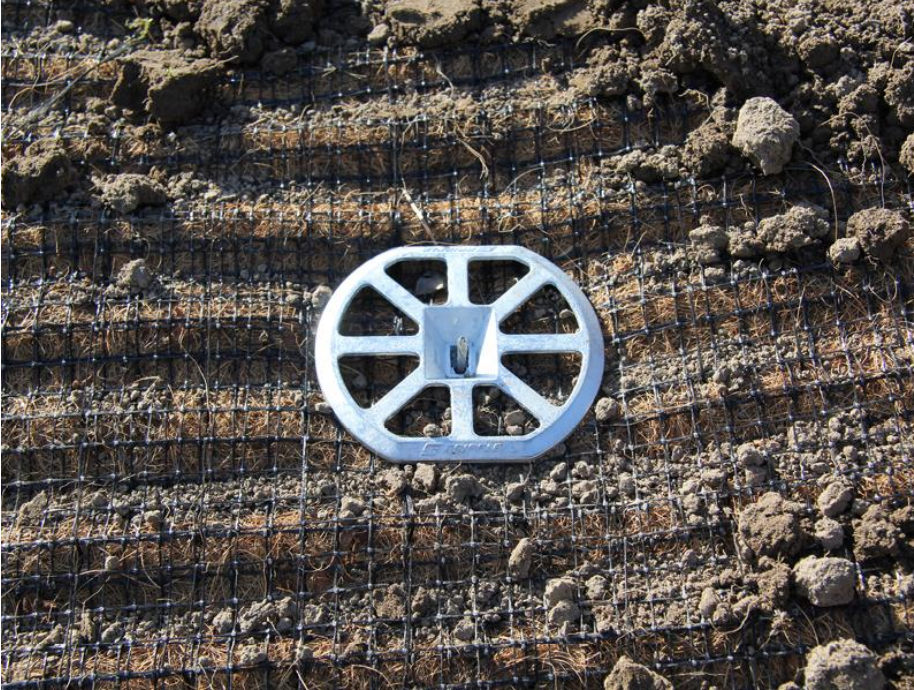
Obrázek 48: Detail ukotveného materiálu pomocí systému Terra lock. Zdroj: https://www.gripple.com
