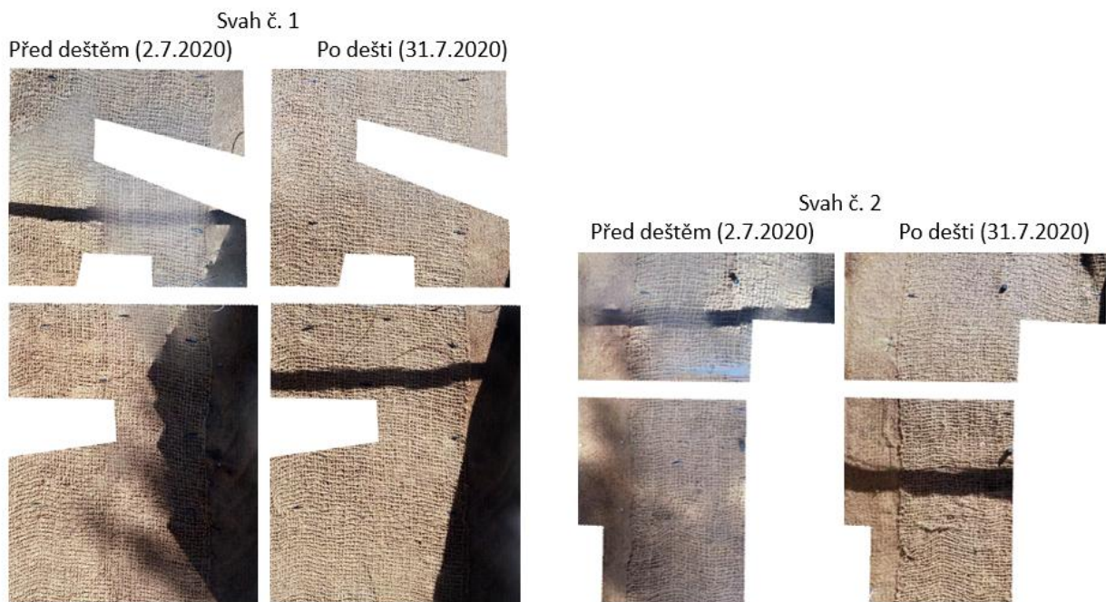
Obrázek 30: Ortofoto snímky svahu č. 1 a 2 po instalaci zakrytí a po srážkových událostech.
